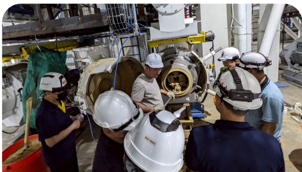
不定期重點工程安全巡視（一）
