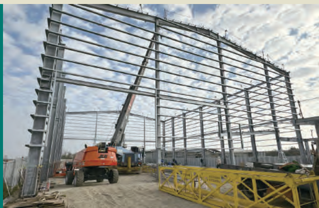
六腳場新場建設情況 廠房與辦公室的鋼樑組裝工程完成
